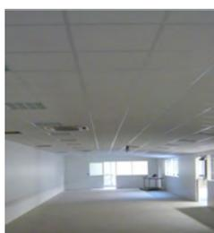
Faux-plafond, ossature apparente, dalles 600 x 600 mm
