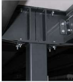
Jonction poteaux plateforme multi-niveaux
